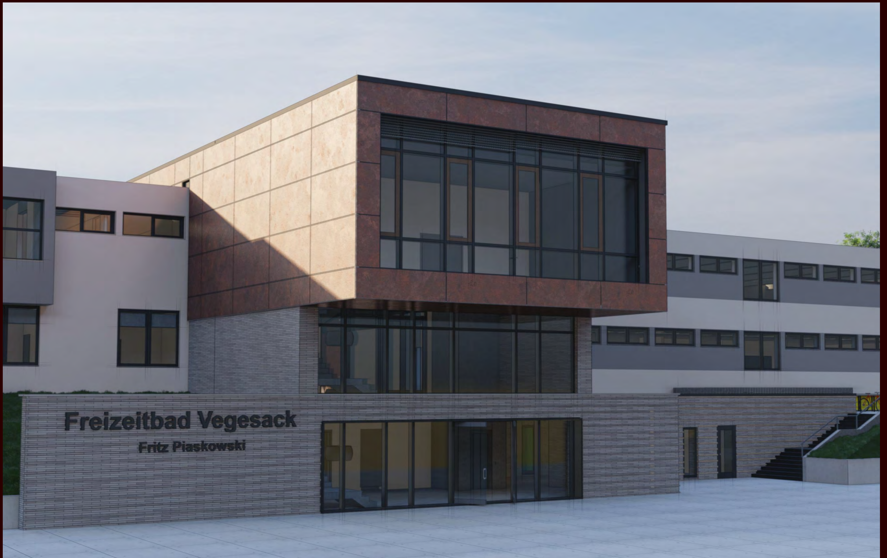
Freizeitbad Vegesack, Teilneubau und Sanierung
